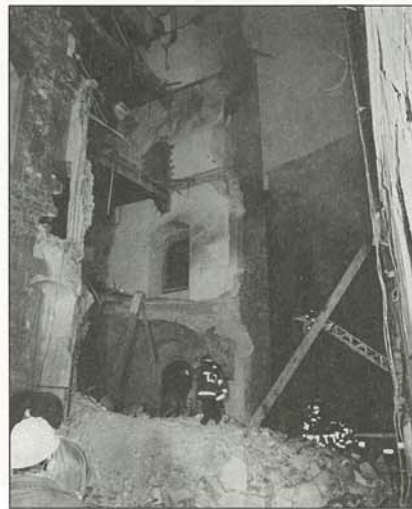
Il palazzo dell'Accademia dei Georgofili dopo lo scoppio della bomba
